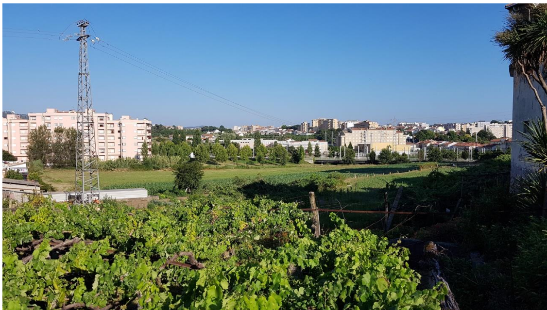
Figura 4-33– Vistas da zona do Futuro Parque de Estacionamento de Rio Tinto (Julho de 2019)
