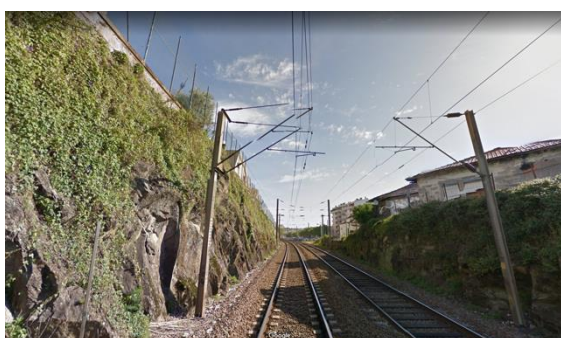
Figura 4-21– Troço, próximo ao km 4+300, entre taludes íngremes, acompanhados por áreas urbanas
