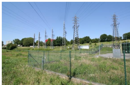
Figura 4-29 – Presença de estruturas da rede elétrica
