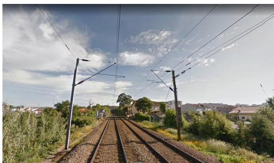
Figura 4-23– Passagem do troço numa área urbana dispersa
