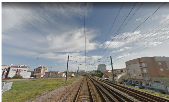
Figura 4-32 – Chegada à estação de Ermesinde, o troço desenvolve-se ao nível da malha urbana, acompanhado por áreas de prado espontâneo
