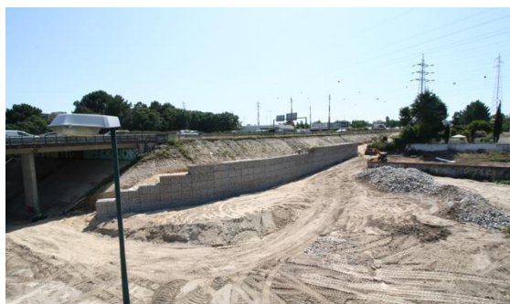
Figura 4-30 – Obras junto a autoestrada e linha férrea
